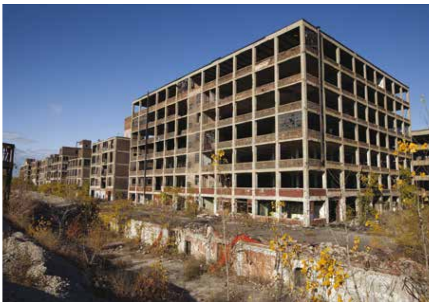
L'ancienne usine Packard de Detroit. À son apogée, elle employait 40 000 personnes.
