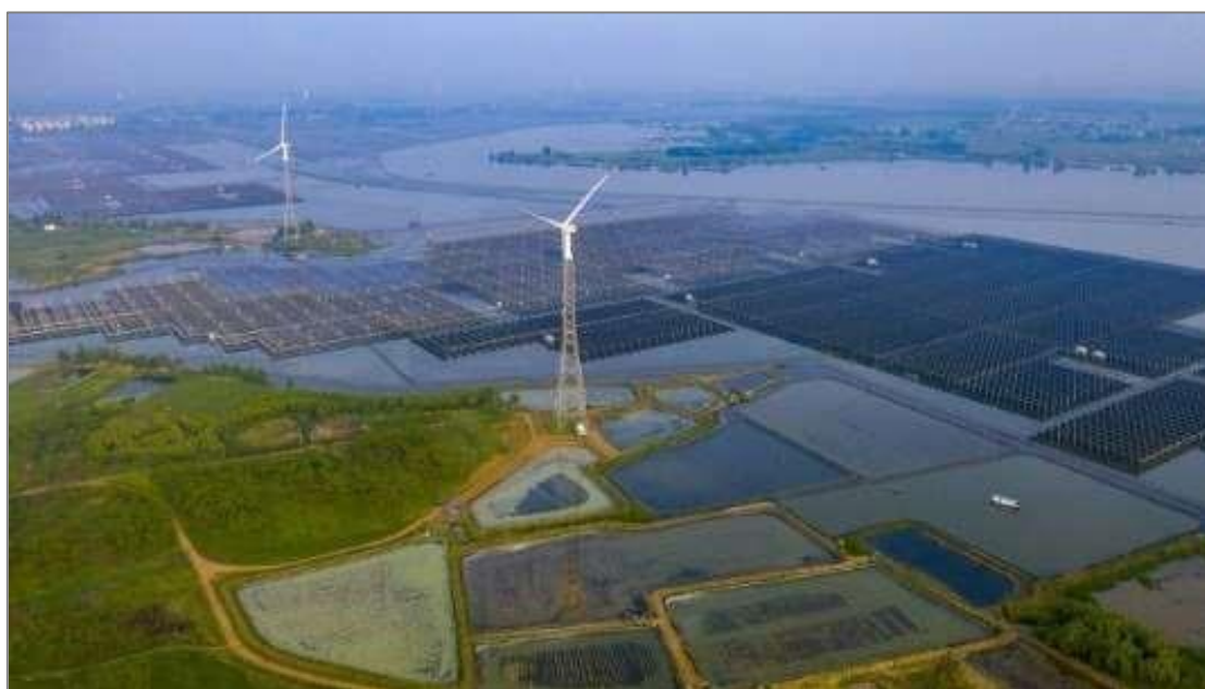
Figure 13 : Projet de production d'hydrogène, province du Shandong Source : www.lesechos.fr
